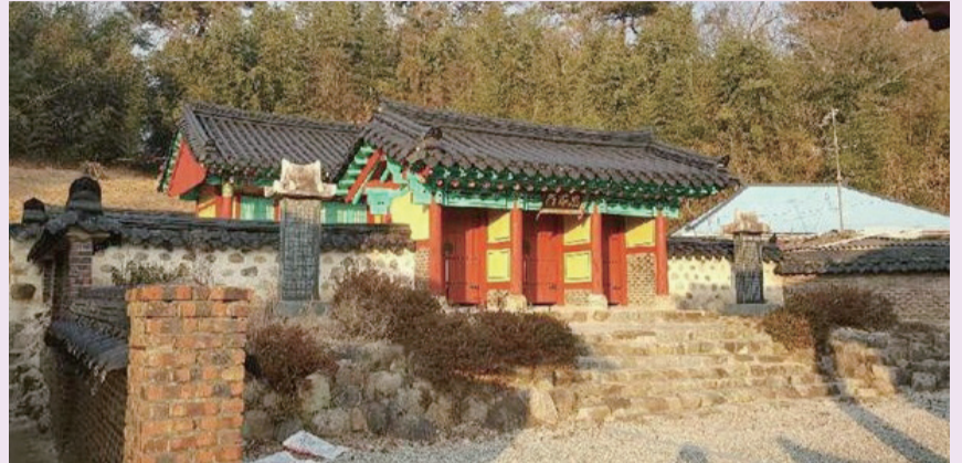
전남 장성군 삼서면 유평리 373번지 부귀마을의 표의사 전경
