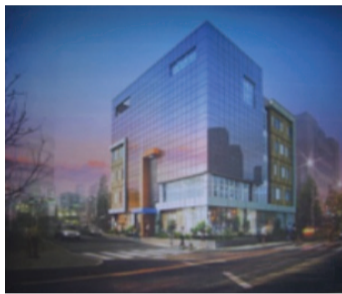
준공된 건물 전경 사진 대지 307평 건평 1,022평 지하1층, 지상6층
