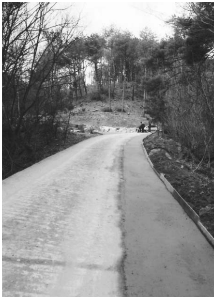
▲시조산소 진입로 확장공사
